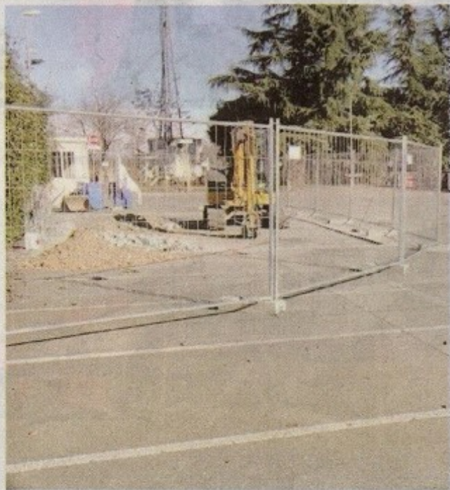
Il lavori di installazione della nuova pesa alla piattaforma ecologica di Santo Stefano
